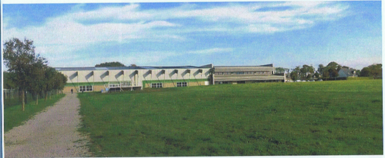
Photographie du secteur
