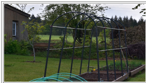
Montage de la structure en 2015
